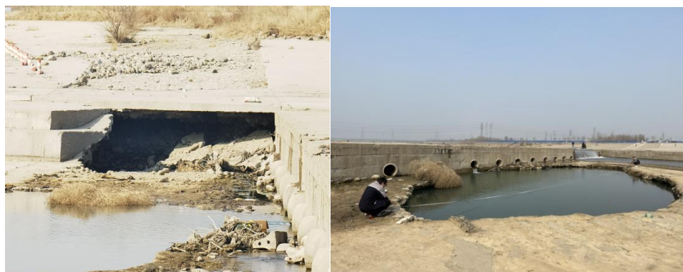
图 1-1 河道护砌冲毁陶刷
