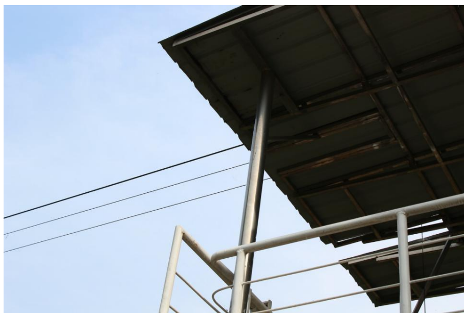
张家坟水文站缆道
